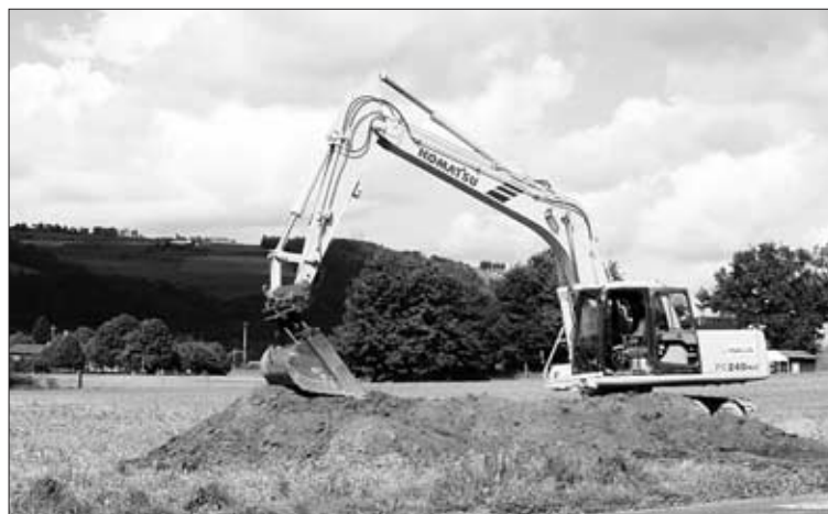
Nach der Zwischenbegrünung des Unterbodens erfolgt der Auftrag des Oberbodens. Bild: KAGA
