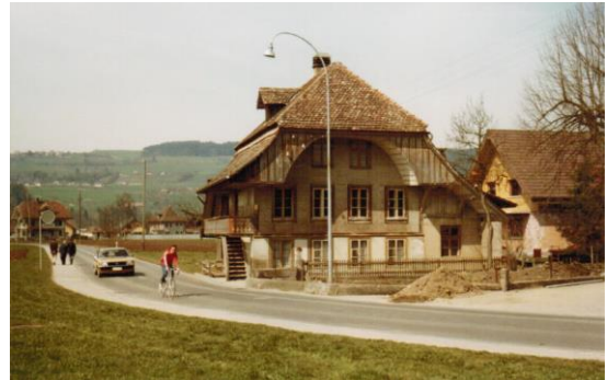
Engimannstock, Trottoir über Bach beachten
