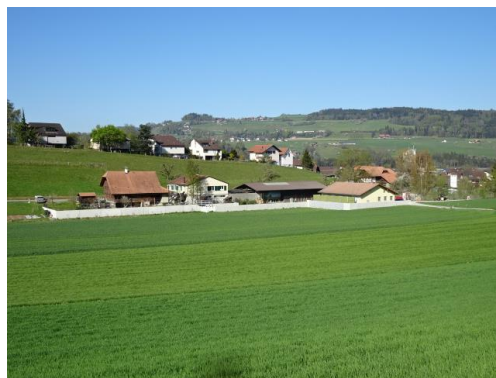
Ein spezielles Bauwerk: Rückhaltung Schützenhaus
