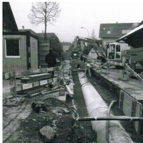
Bachleitung im Dorf
