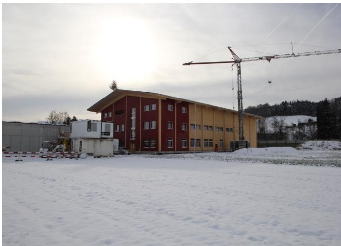
Vor der Fertigstellung
