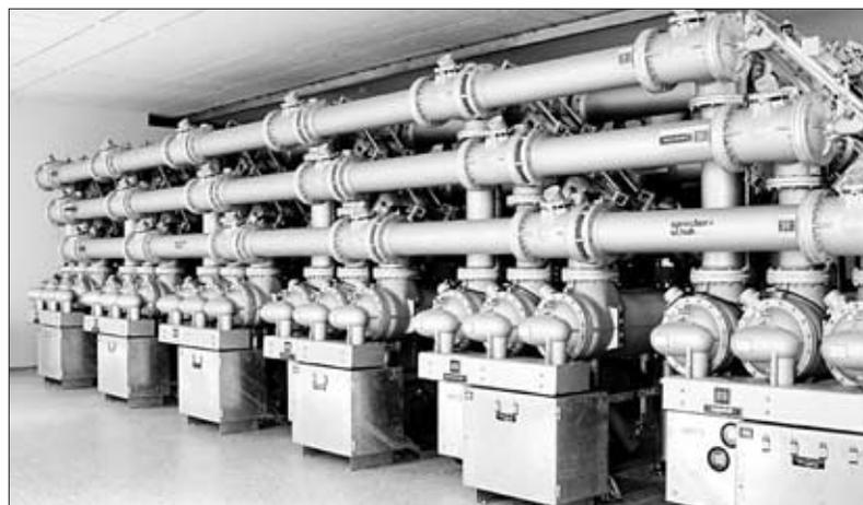
Die Schaltanlage im 1. Stock für die 132kV-Leitungen.
