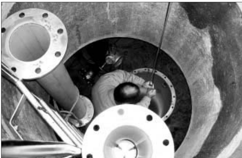
Kanalfernsehen des Brunnens am Mittwoch, 9. November 2005.
