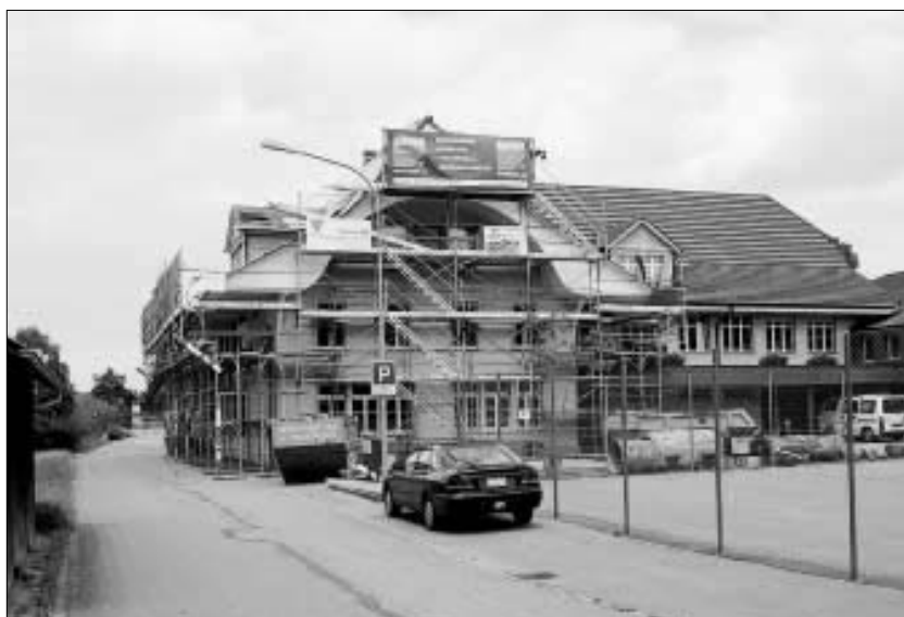
Das eingerüstete Schulhaus am Bach.
