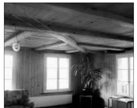
Der diagonale Balken im 2. Stock. Bilder mgo
