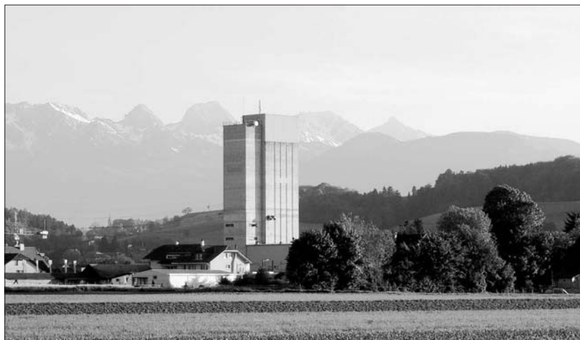
Die Nordseite des grossen Silos.
