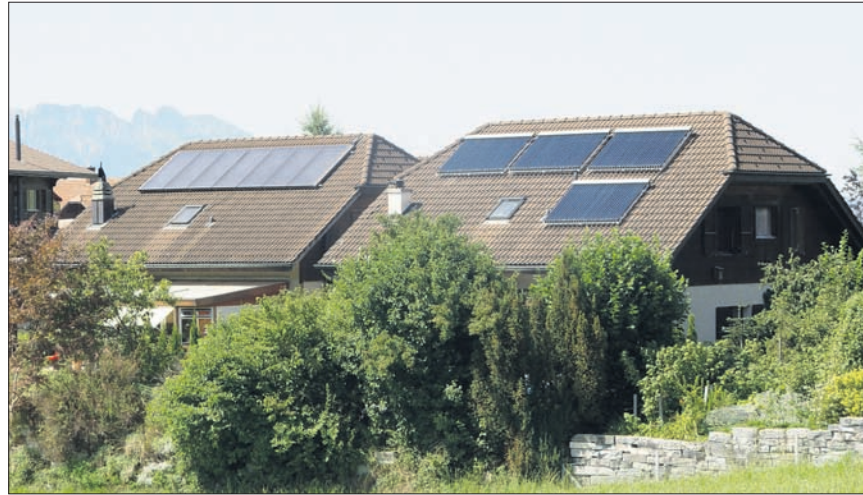
Flach- (links) und Röhrenkollektor (rechts).
