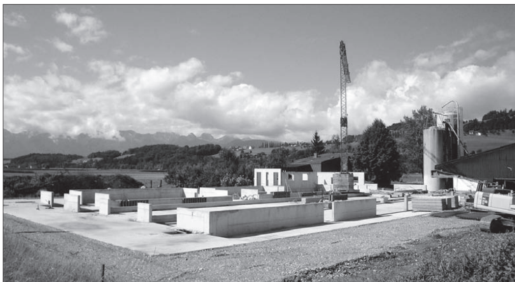
Bau der neuen Stallung der Familie Baumann.
