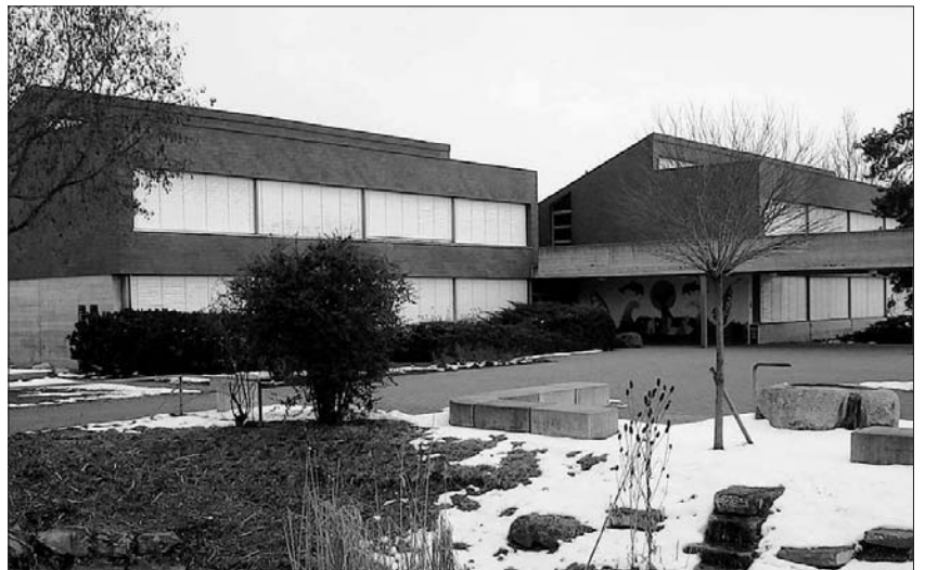
Das Verdikt der Stimmberechtigten war deutlich: Das Stadelfeld-Schulhaus kann der dringenden nötigen Renovation unterzogen werden. Bild: PL
