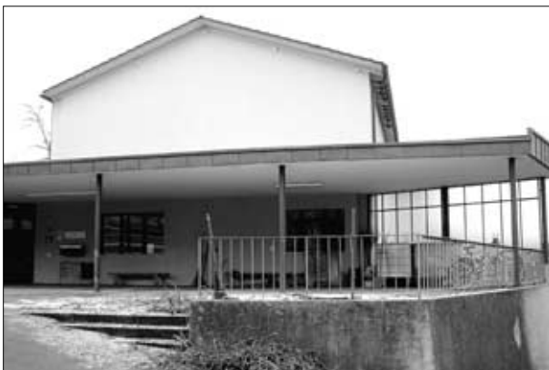
Freier Blick aufs Schulhaus. Hier soll in den nächsten Wochen ein neuer Baum gepflanzt werden. Bilder HR. Blatti
