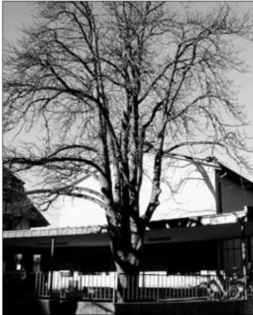
Die Rosskastanie steht zu nahe am Schulhaus.
