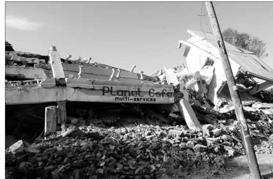
Typische Destruktion eines verheerenden Erdbebens. So geschehen mit zigtausend Gebäu-den: Zerfall mehrerer Stockwerke.
