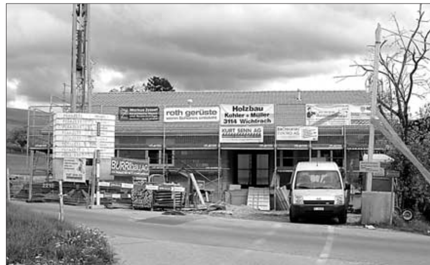
Gegen Ende der Bauphase.
