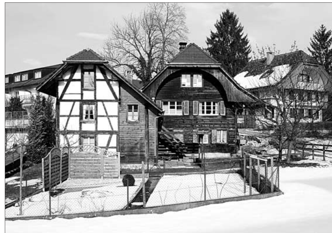
Die ehemalige Kleedrescherei von Süden.
