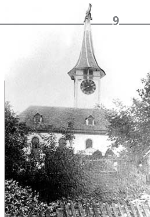
Der Turm nach dem Brand von 1913. OW, S.177
