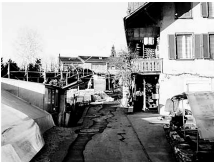
Wohnhaus und Gärtnerei vor dem Umbau.
