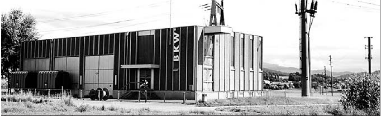
Die BKW-Unterstation an der Kreuzung Siedlungsstrasse-Wässerigweg.
