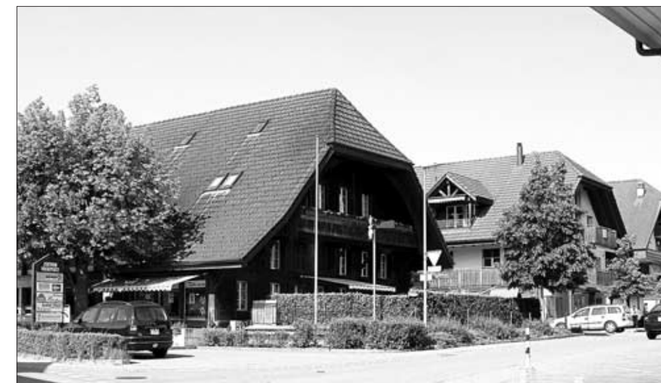
Das Zentrum Kreuzplatz ist seit 10 Jahren in Betrieb.
