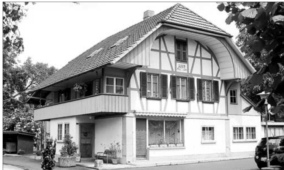
Die frühere Käserei/Bäckerei an der Schulhausstrasse.
