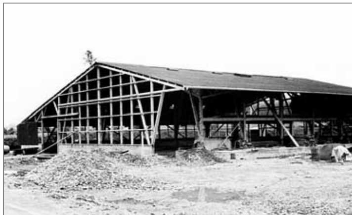
Der Rohbau der Scheune des Steinackerhofs steht.
