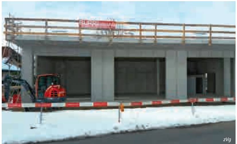
Der neue Werkhof steht im Rohbau.
