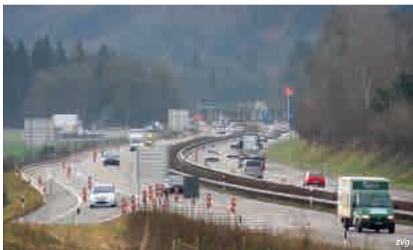
Vorbereitungsarbeiten in Rubigen.
