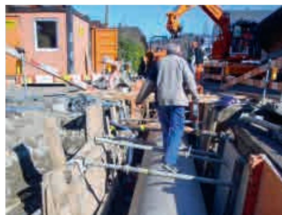
Bei den neuen Rohren handelt es sich um glasfaserverstärkte Kunststoffrohre, Innendurchmesser 1m, Länge 6m.
