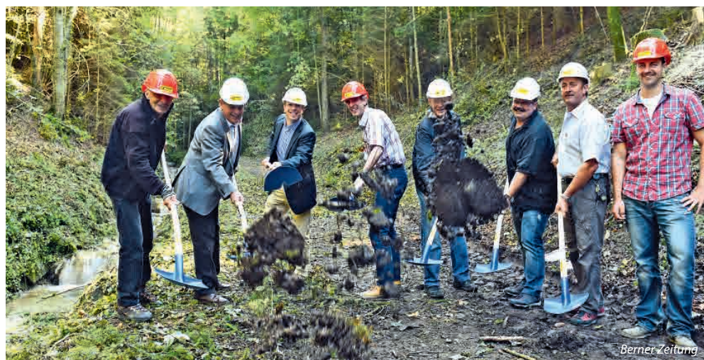
Spatenstich im Gansgraben.
