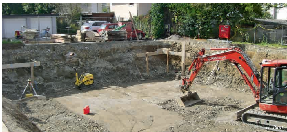
Der Aushub ist gemacht.
