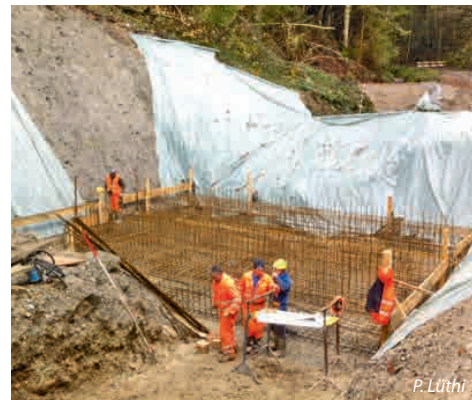
Hier entsteht der Geschiebesammler.
