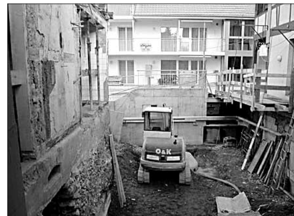
Bagger in der Baugrube des Zwischenbaus.
