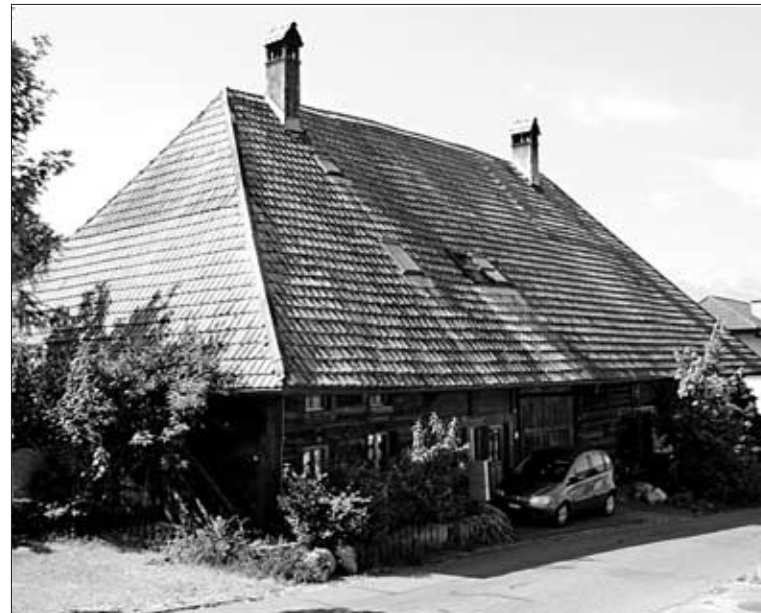
Ansicht von Norden (von der Oberdorfstrasse). Bilder mgo
