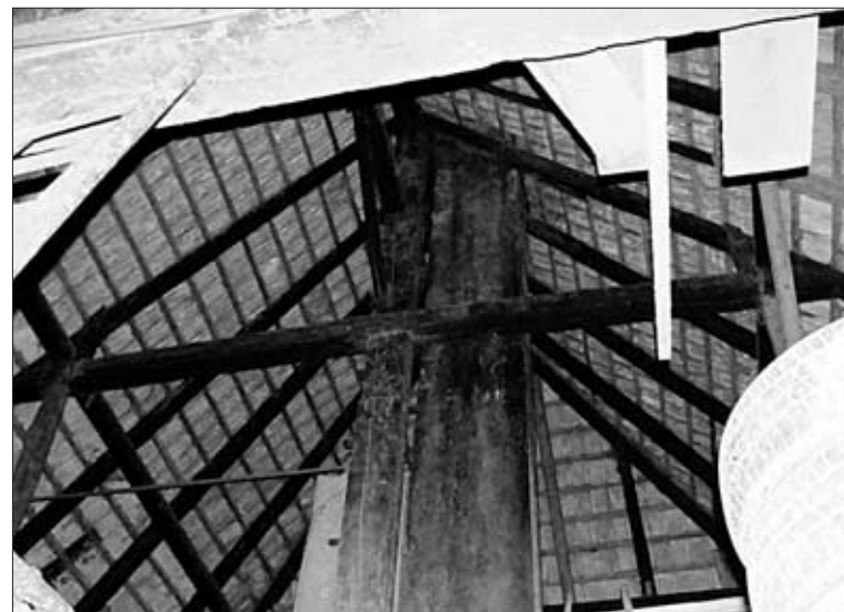
Ein Blick in den gewaltigen Dachstuhl.
