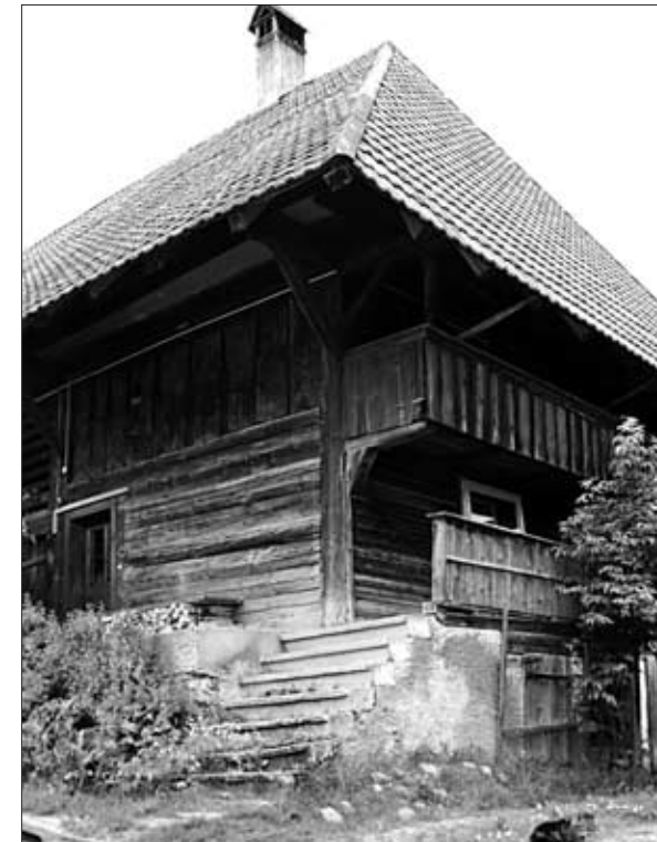
Die westliche Ecke mit ursprünglichen Fassadenteilen.
