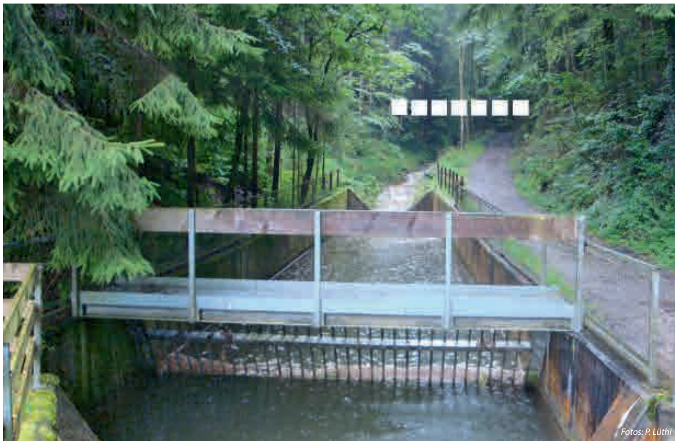
Lage des ersten Bauobjektes im Gansgraben.
