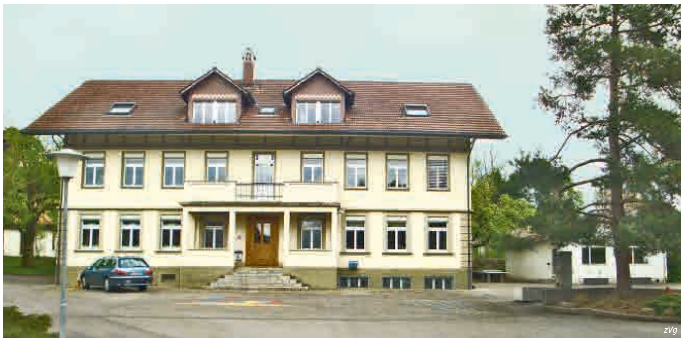
Das Kirchstrasseschulhaus soll für andere Gemeindeaufgaben umgenutzt werden.
