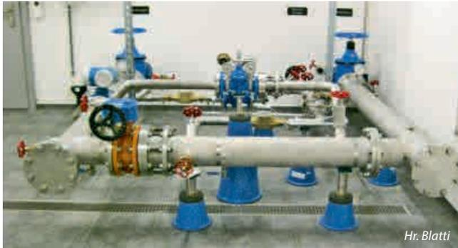
Das Herzstück der neuen Verbindung. Links kommt das Wasser von Münsingen, rechts von Wichtrach; durch die kleinen Rohre bezieht der Alterssitz Neuhaus das «Mischwasser». Mit dem schwarzen Rad im Vordergrund werden die beiden Netze verbunden und das Wasser fliesst durchs grosse Rohr je nach Bedarf nach Wichtrach oder Münsingen.
