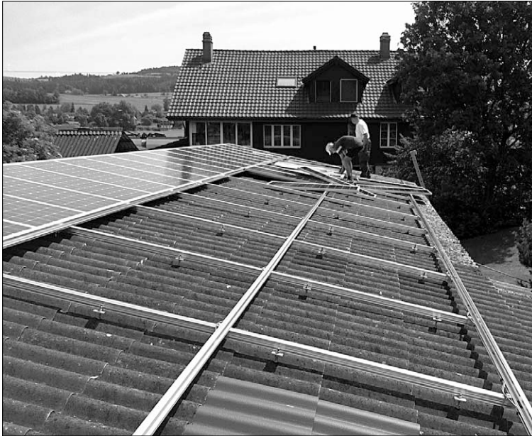
Die Solarmodule werden in die vorbereitete Halterung gesteckt.
