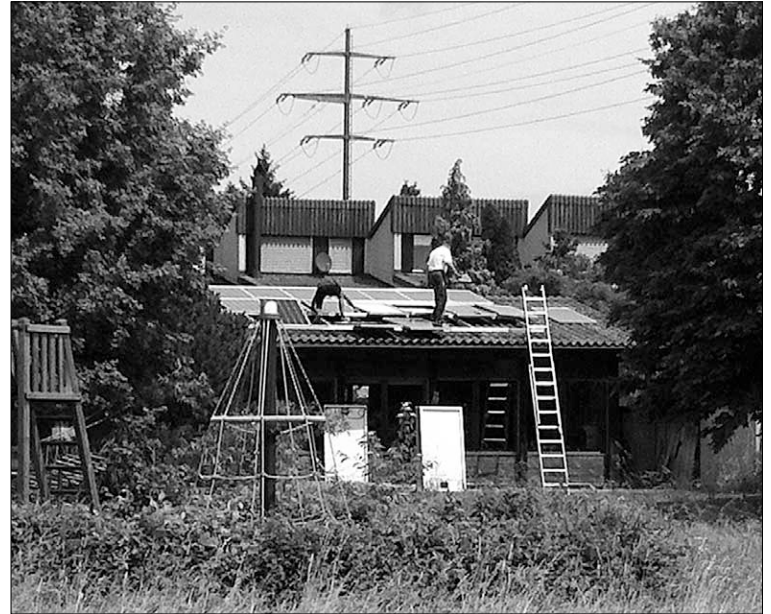
Bald ist das Süddach vollständig belegt.
