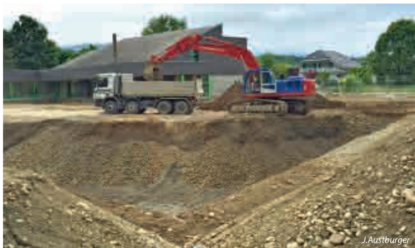
Baugrube beim Stadelfeldschulhaus.
