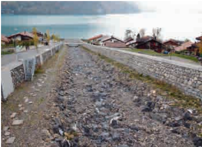
Wasserschutzbau (Raubettgerinne) Glyssibach heute.
