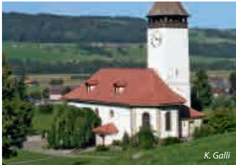
Das Kirchendach mit den neuen Biberschwanzziegeln.
