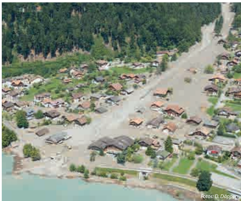
Schadensbild in Brienz vom Glyssibach am Tag danach.
