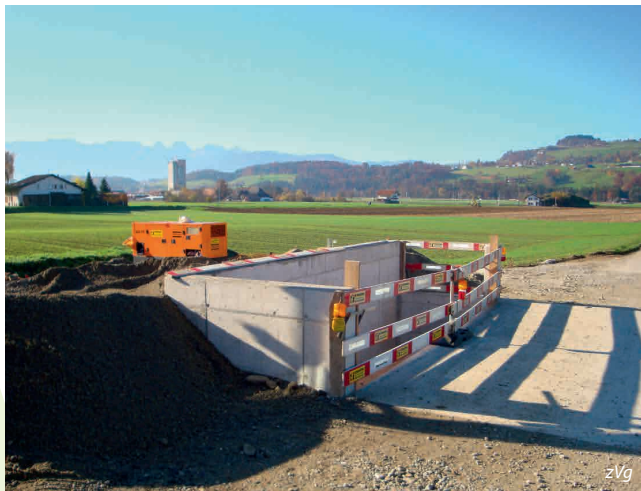
Hochwasserentlastung am Lochweg
