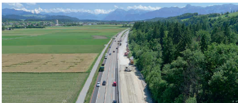
2016 wird der A6-Abschnitt Niederwichtach-Kiesen gesamterneuert.
