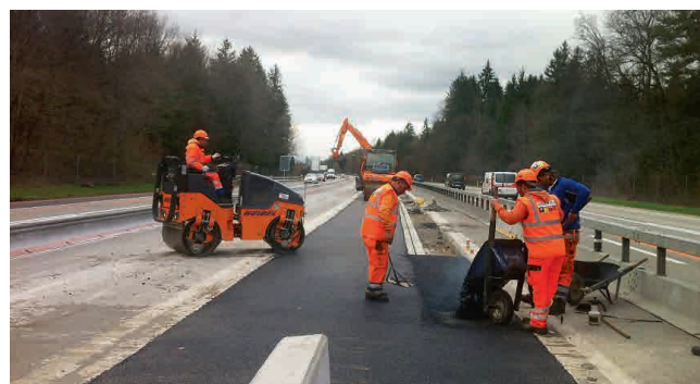
Wie schon 2015 erfolgt die Erneuerung in mehreren Etappen.
