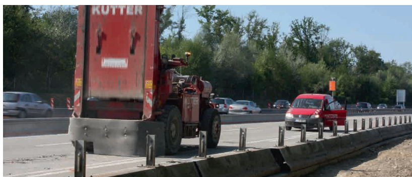
Die Zertrümmerung der alten Betonfahrbahn sorgt zeitweise für Lärm.
