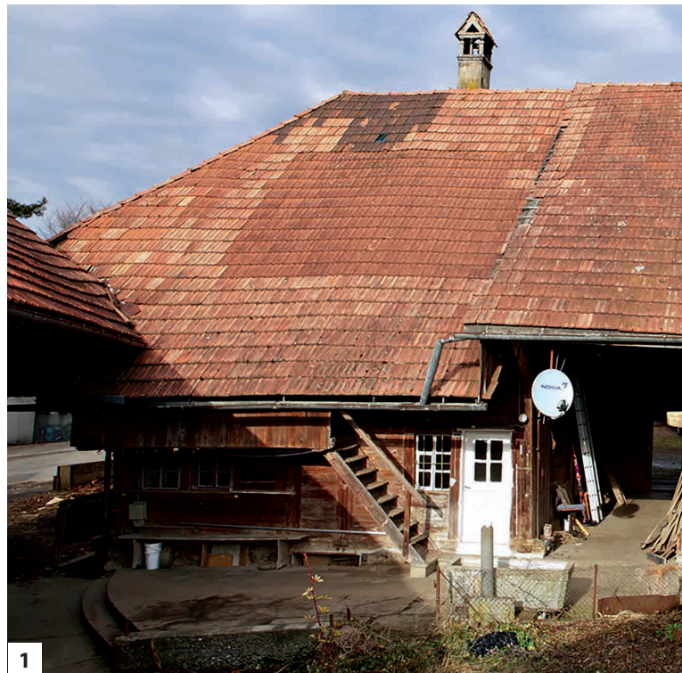
1 Das Mehrfach-Taunerhaus von der Südseite. Das nachträglich angehobene Dach der östlichen Hausteile bringt die Uneinheitlichkeit des Gebäudes zum Ausdruck.
