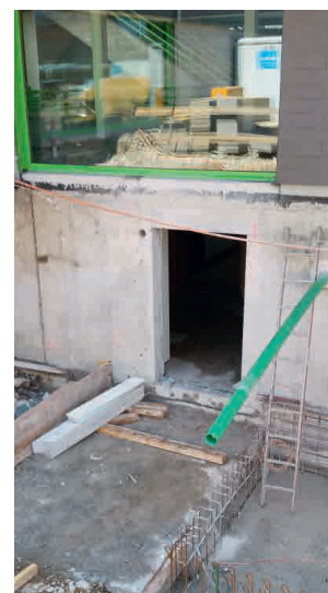
Durchbruch zum Schulhaus.
