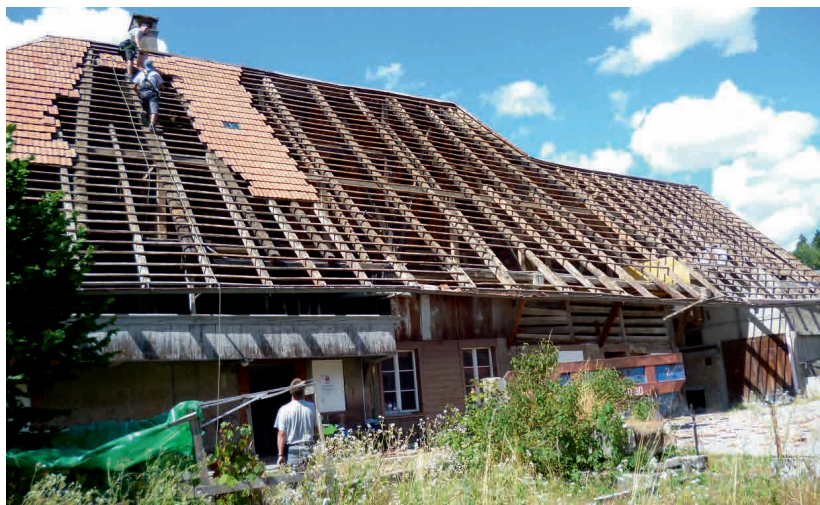
Die Dachdecker werfen jeden einzelnen Ziegel zielsicher in eine Mulde.
