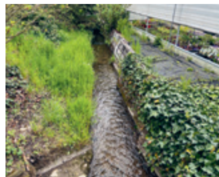
Vor Sanierung: unterer Teil
