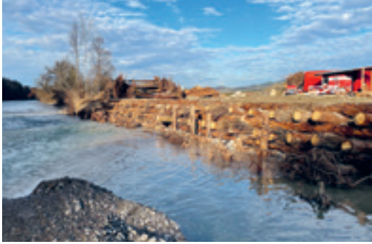
Holzlängsverbau bei der Neurüti
