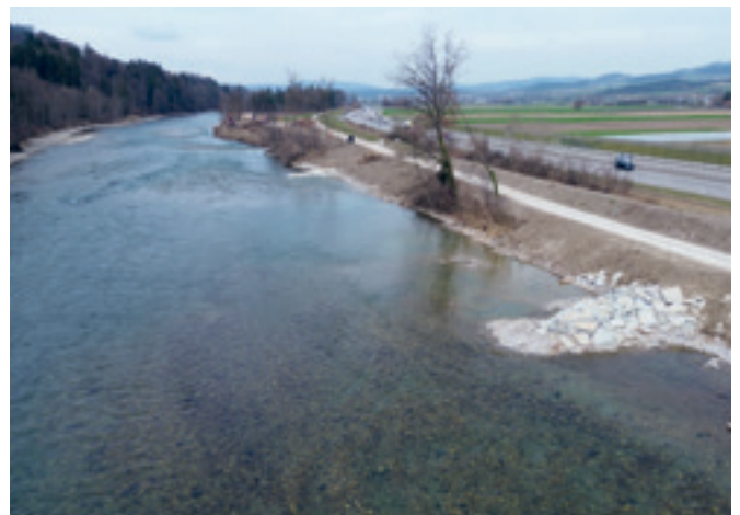
Blocksteinbuhnen rechtsufrig bei der Thalgutbrücke
