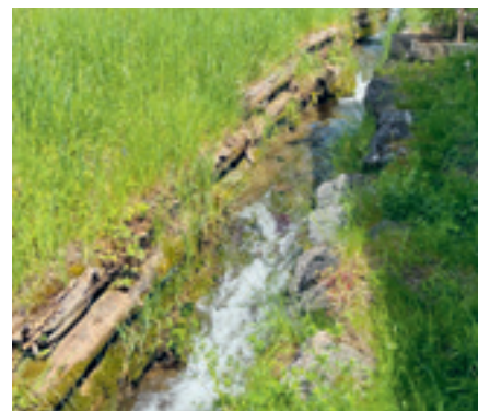
Vor Sanierung: oberer Teil
