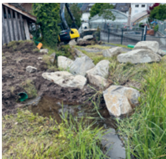
Der Bach wurde während den Bauarbeiten umgeleitet
