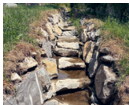
Nach Sanierung: oberer Teil
