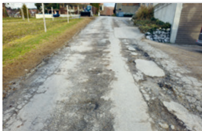
Dieser Abschnitt des Leuerewegs wird saniert
