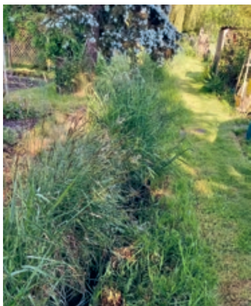
Zugewachsener Talibach zwischen Fusswegbrüggli und Schützenhaus, Perimeter B
