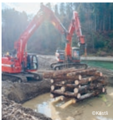
Die Ufer werden mit Wurzelstammholz stabilisiert. Die Holzstrukturen sind mit ihren Hohlräume wertvoll für Fische.
