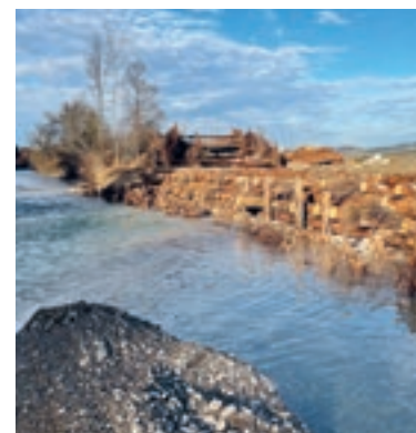
Die Ufer werden mit Wurzelstammholz stabilisiert. Die Holzstrukturen sind mit ihren Hohlräume wertvoll für Fische.
