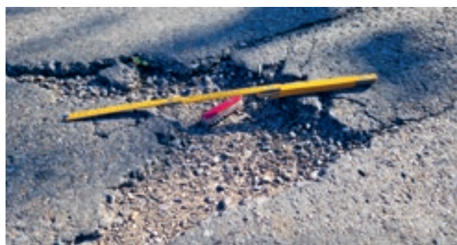
Mit der Sanierung der Gutstrasse wird im Herbst gestartet
