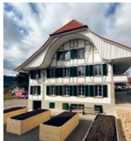
Die sanierte Südfassade
