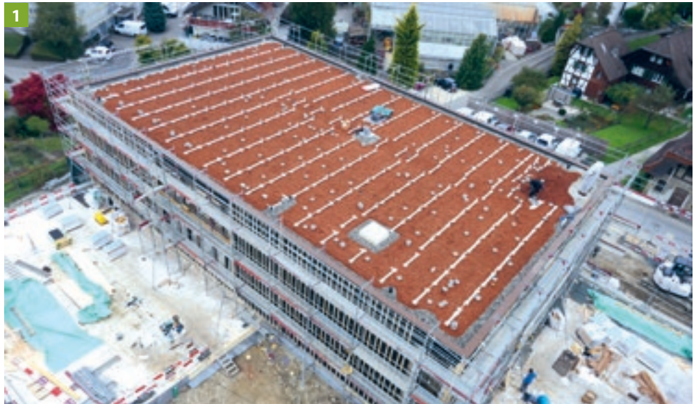
Endausbau Flachdach und Vorinstallation für die Fotovoltaikanlage
