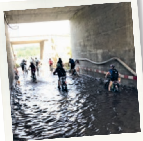
Bahnunterführung bei der Uttigenbrücke
