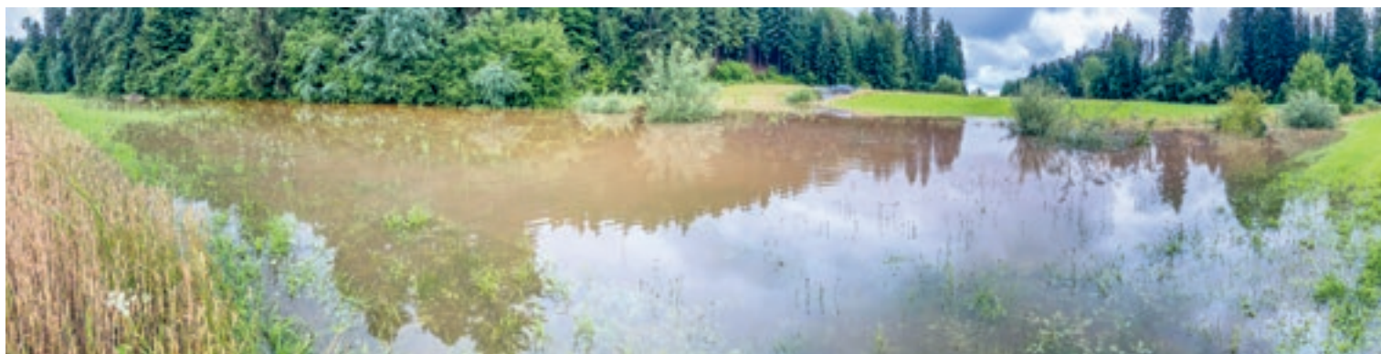
Rückhaltebecken Heiegraben am 13. Juli 2021 (Damm oben rechts ersichtlich)
