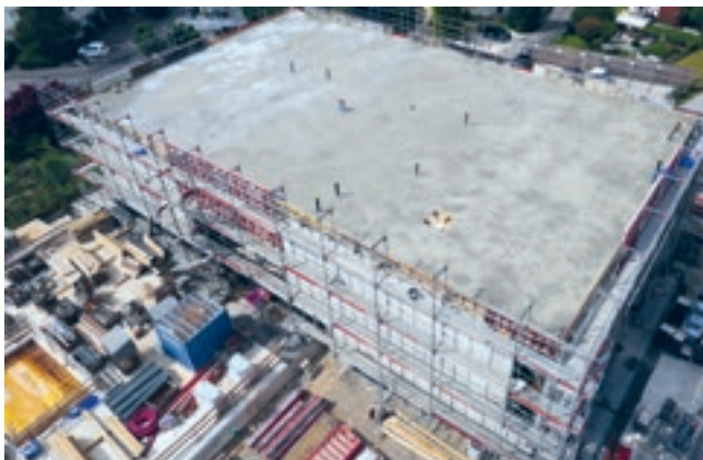
23. Juli 2021 Ende Rohbau Decke über 1. OG
