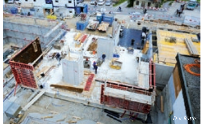
Eingangsbereich mit Liftschacht, vom Sockel- zum Erdgeschoss 27. April 2021.
