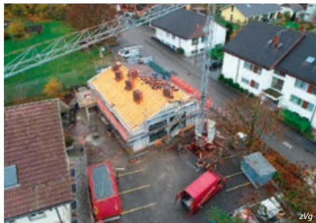
Der Bau des neuen Musiklokales in Wichtrach nimmt erstmals Form an.
