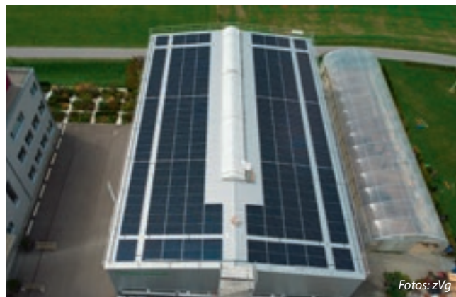
Solaranlage des Ausbildungszentrums der Gärtnermeister, Campus Baumat.
