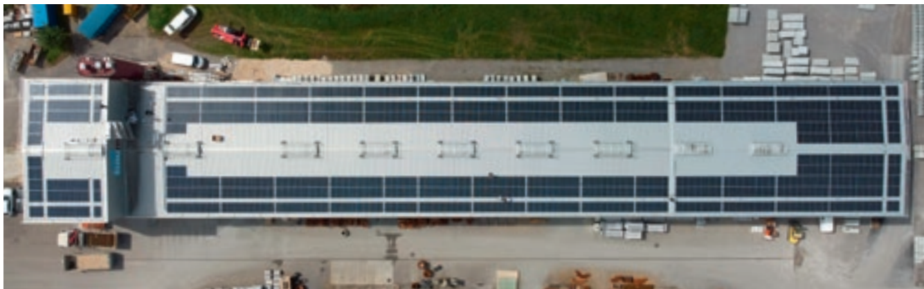
Solaranlage auf dem Dach der Betonwarenproduktion.
