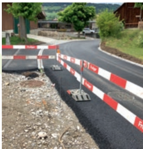
Die Hauptarbeiten sind abgeschlossen.
