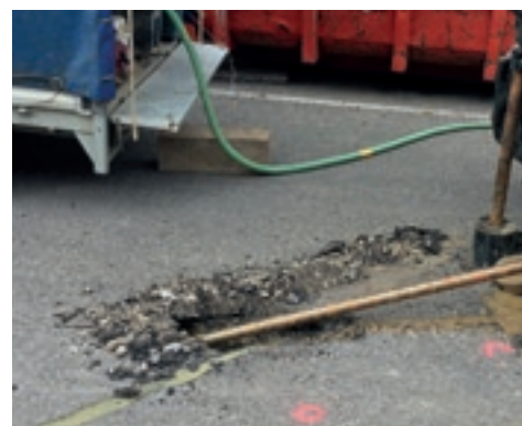
Spülbohrung (Querung der Kantonsstrasse mit der neuen Trinkwasserleitung)
