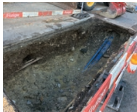
Startgrube für Spülbohrung
