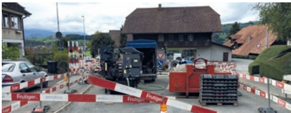
Installationsplatz für Spülbohrung
