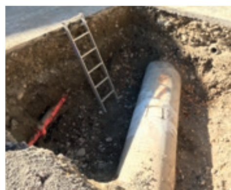
Sondage diverse Leitungen
