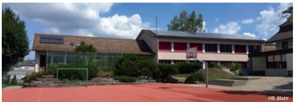
Diese Gebäude sollen ersetzt werden.
