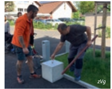
Montage der Sitzblöcke
