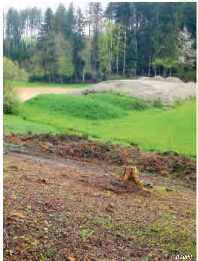
Blick auf Materialdeponie Heiegrabendamm.
