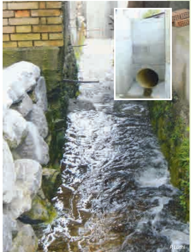
Blick offener Bachteil Gansgraben. Detailansicht: Bacheinlauf Südseite.
