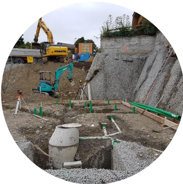
Kanalisationsabnahme (vor dem Eindecken)
