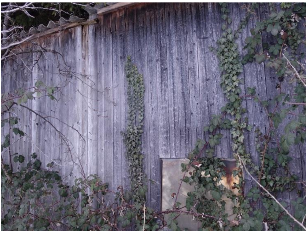
Abbildung 5c. Efeu Hedera helix klettert an der Lärmschutzwand empor.
