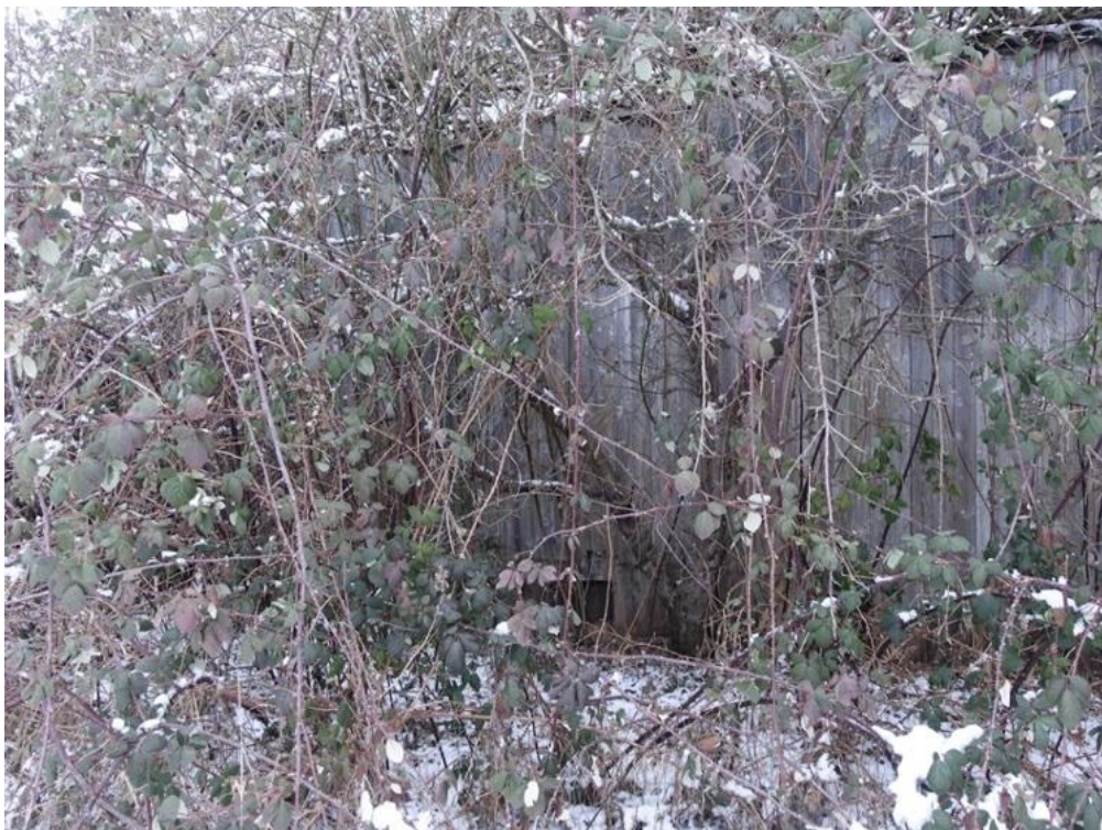
Abbildung 5d. Brombeergestrüpp entlang der Südseite der Lärmschutzwand.
