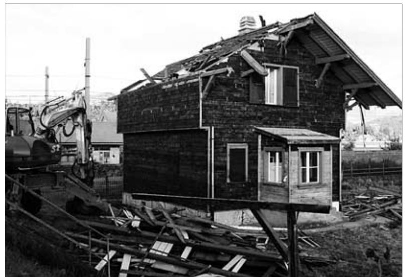
Juli 2008: Die Abbrucharbeiten haben begonnen.
